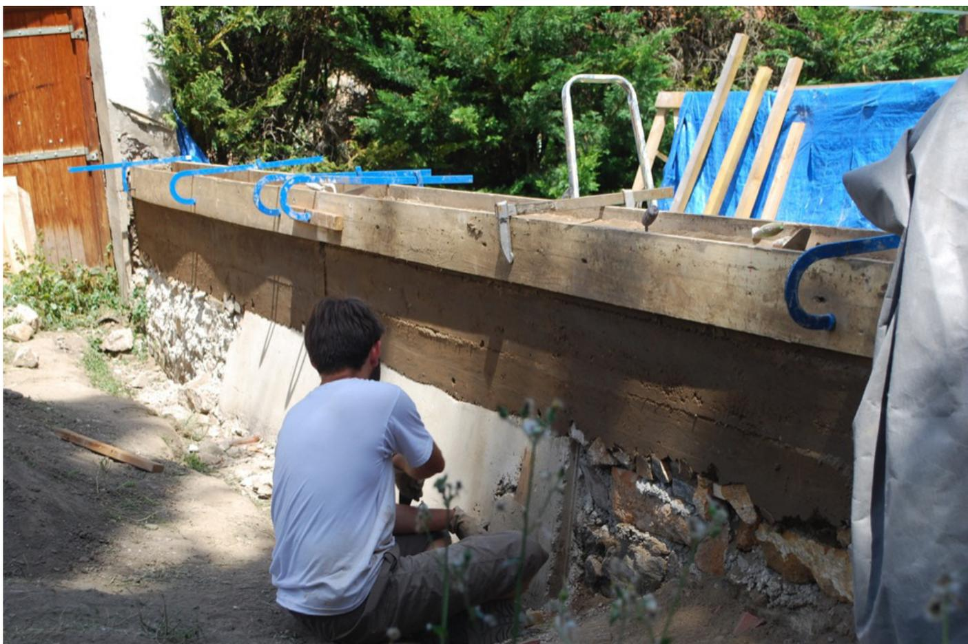
Un autre coffrage est nécessaire pour la finition avec le béton de chaux
