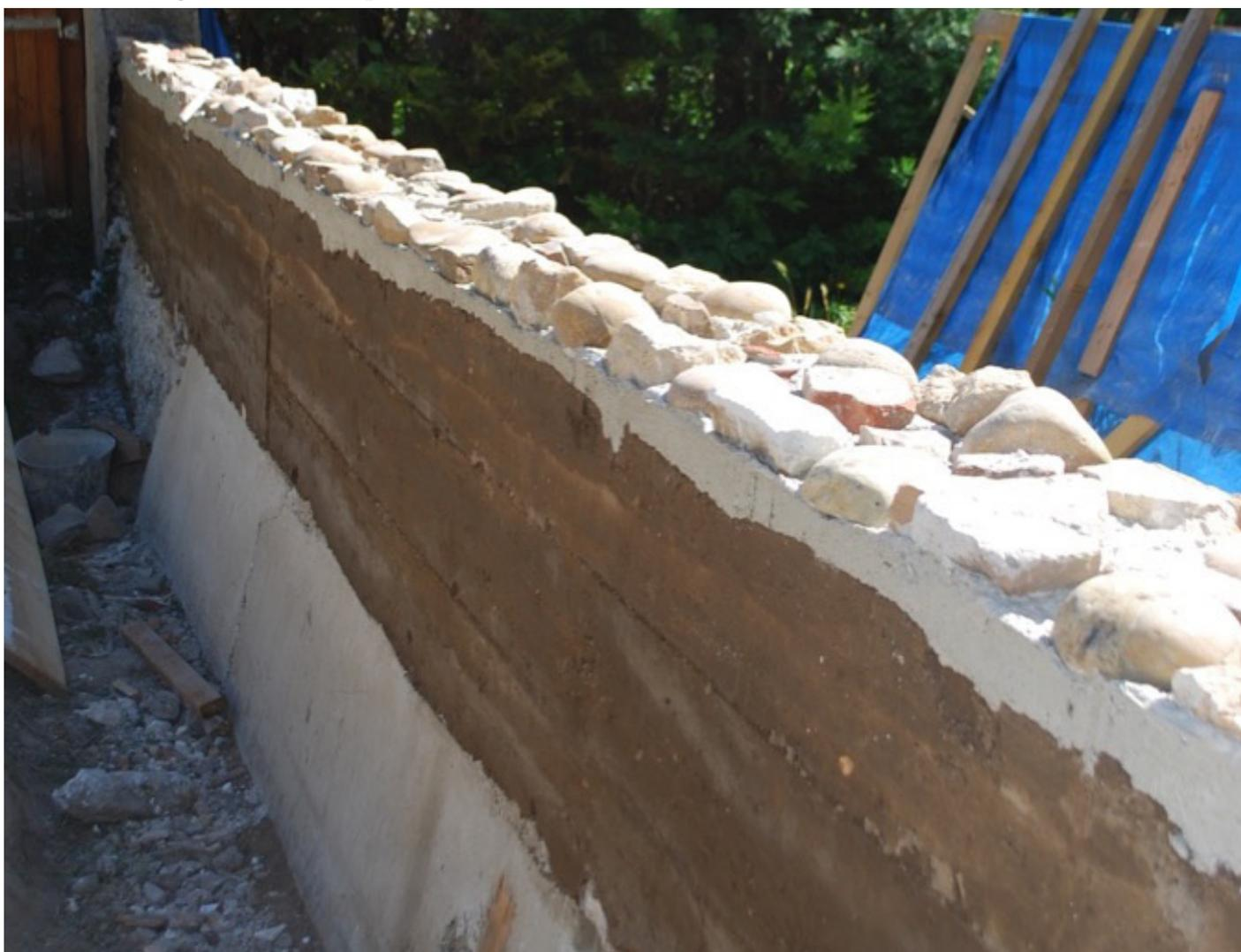
Dans notre cas la finition du mur sera en mortier de chaux lissé.
